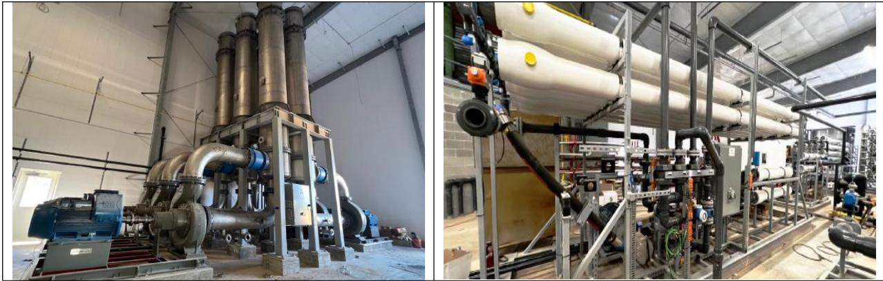
Flotación de aire para separar líquidos de sólidos. Tratamiento de aguas casi potable. Ultrafiltración. Super filtrado con ósmosis inversa.
