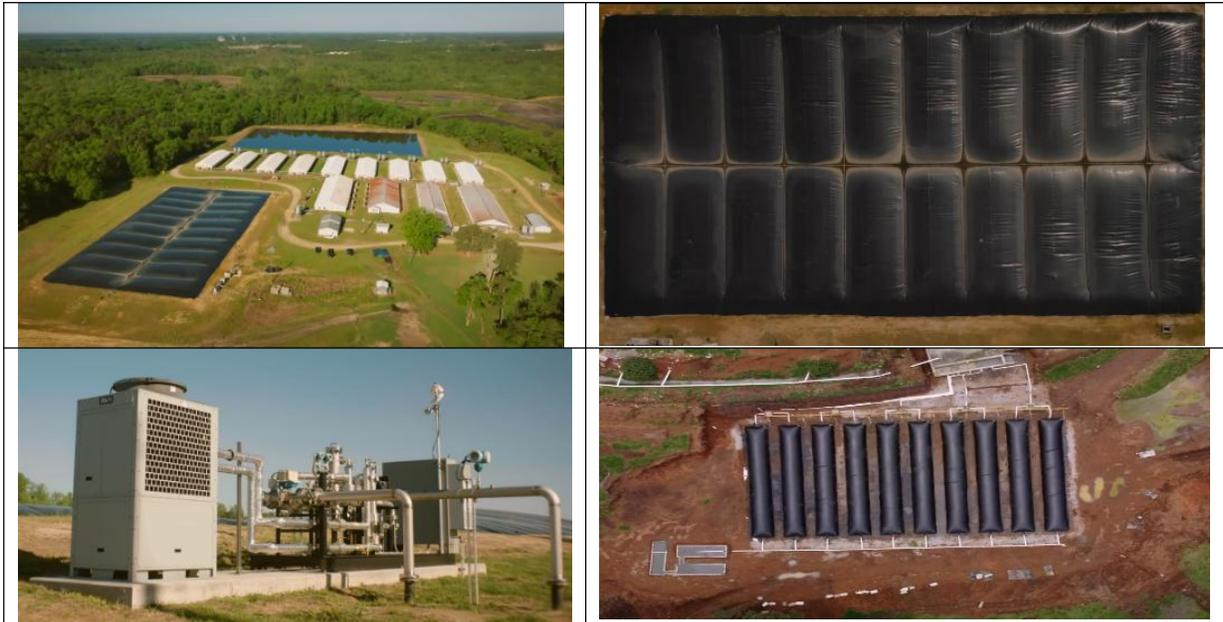
Fotos de Carolina del Norte con laguna de decantación y la instalación de 30 reactores en batería, para generar biogás que pasa de separación de gases para cuantificar los bonos de carbón y generar electricidad con un motor de combustión interna. Y abajo a la derecha en México para 300 cerdas, se diseñaron 10 reactores.
